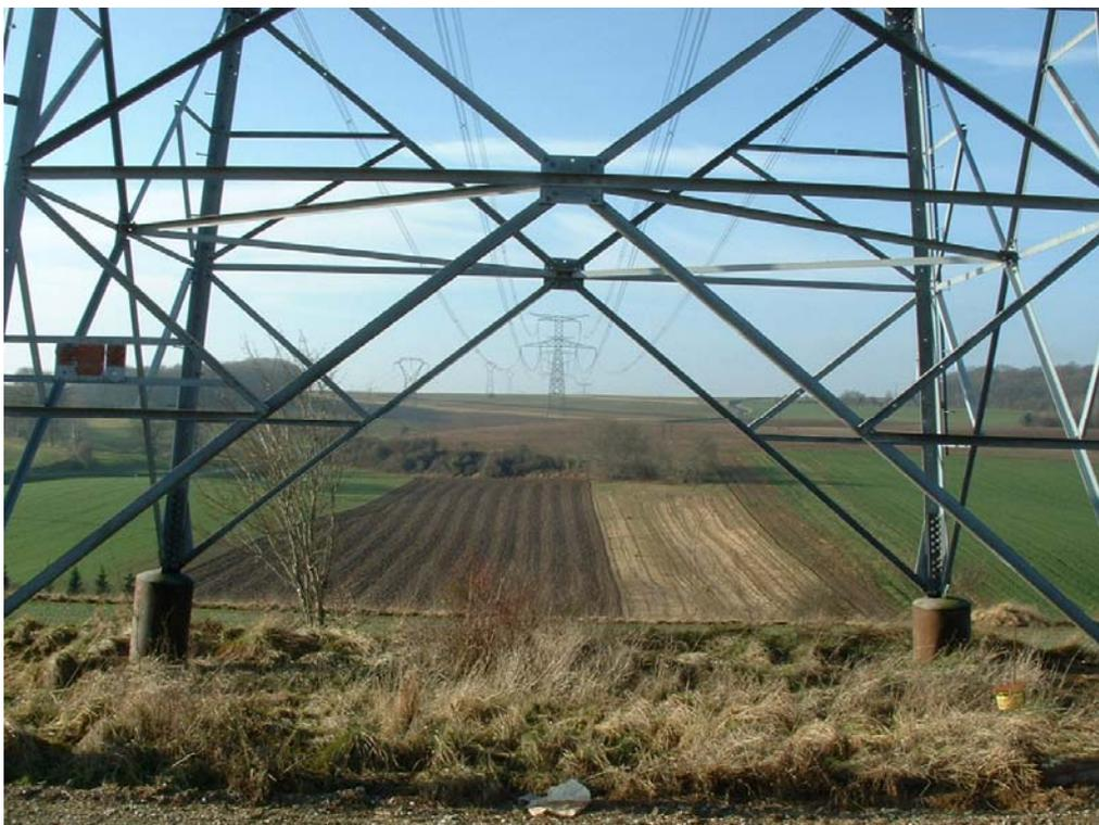
La ligne 400kV de Penly à Argoeuves surmontant la vallée de Hocquincourt à Limeux un total de 26 câbles parallèles (4 groupes de 6 et 2 câbles indépendants. Parallèle à cette ligne de 400kV, la ligne 225 kV (visible sur sa gauche)
