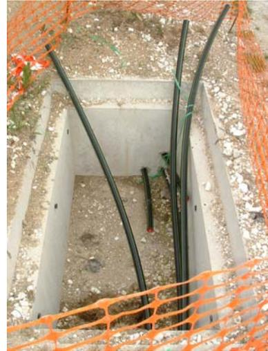
Ci-dessus : la machine creusant les tranchées dans le bord de route et dépose des fourreaux. Les 3 fourreaux présents dans une chambre de tirage (Hallencourt) début mai 2005.
